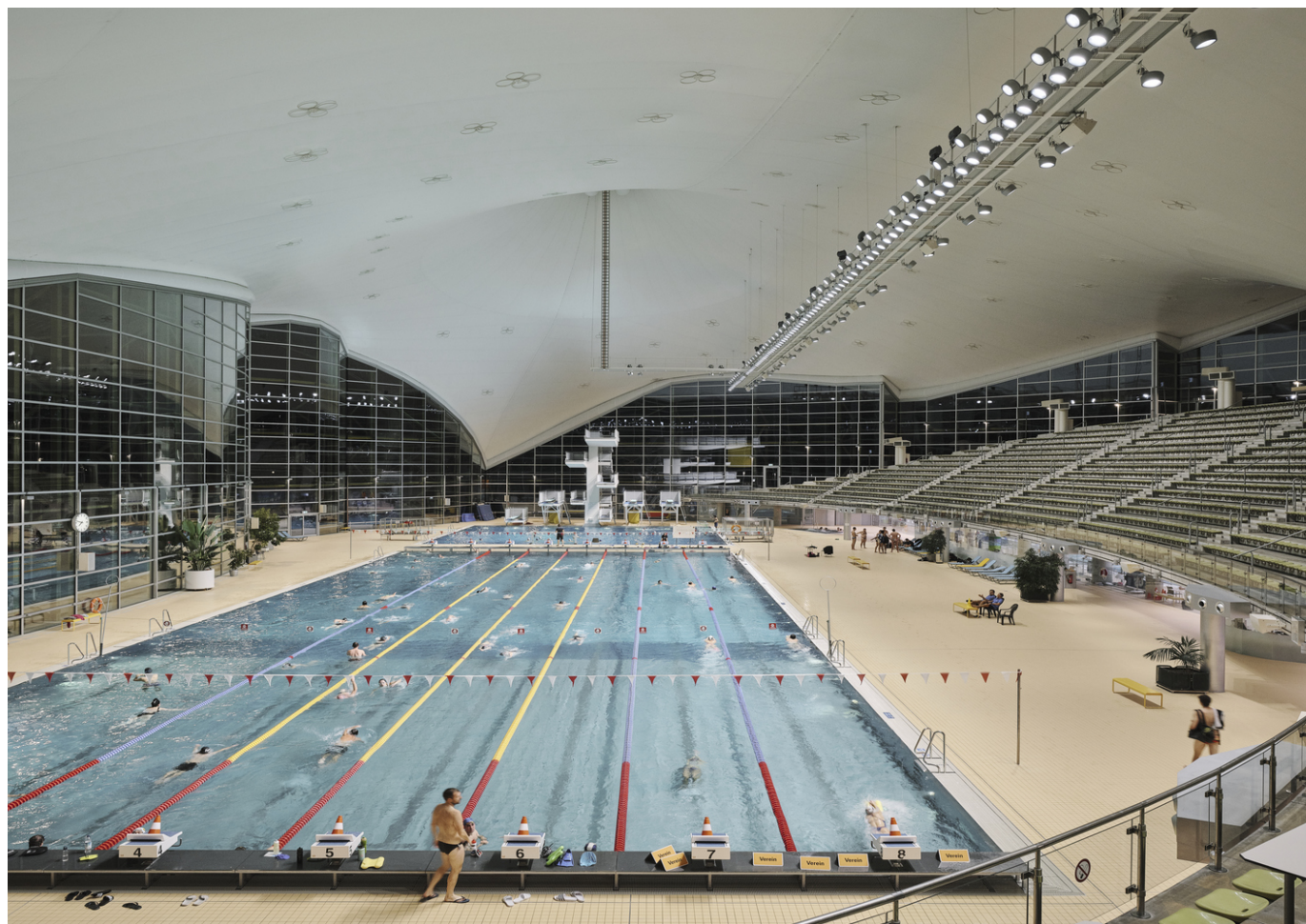
Olympia-Schwimmbad, Monaco di Baviera. Committente: Stadtwerke München GmbH. Architettura: Behnisch & Partner (architettura), Otto Frei (struttura del soffitto), Stoccarda / Planplus GmbH Architekten, Monaco di Baviera (ristrutturazione, rinnovamento, progettazione). Progettazione dell'impianto: Ingenieurbüro Riemhofer, Monaco di Baviera, Paul e Michael Riemhofer, Monaco di Baviera. Progettazione illuminotecnica: 3pi lichtplaner + beratende ingenieure partnerschaftsgesellschaft mbh, Monaco di Baviera, Beatrice Seidt, Florian Zach. Direzione dei lavori: ap architektur und projekte gmbh, Monaco di Baviera. Fotografia: David Schreyer.
