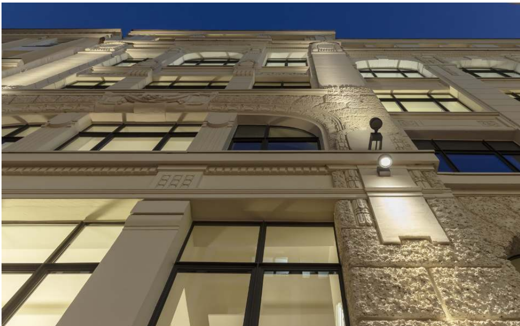
Brüggehaus, Hamburg. Architecture: GRS Reimer Architekten, Hans-Ulrich Zöllner Architekten. Lighting design: list lichtdesign GbR, Hamburg
